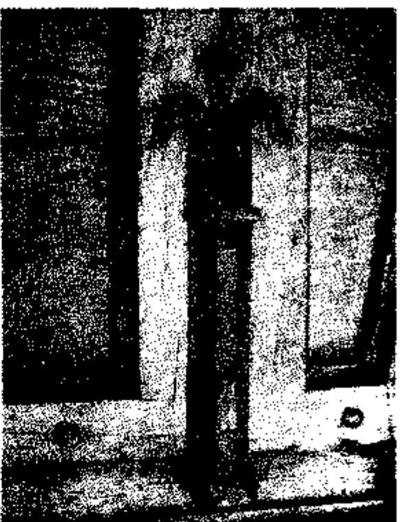
Fig. 10-9 Un perno cuadrado para puerta, sobre una placa que está dividida en su extremo y ha sido moldeada.
