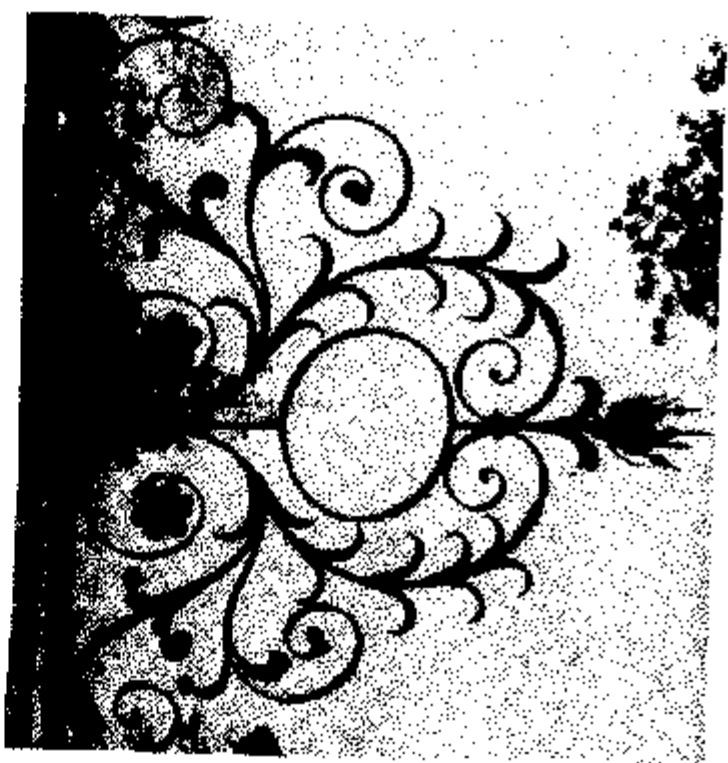
Fig. 11-6 En la parte superior de esta raja de entrecana se utilizan espirales de punta roma con decoraciones de rosetas forjadas.
